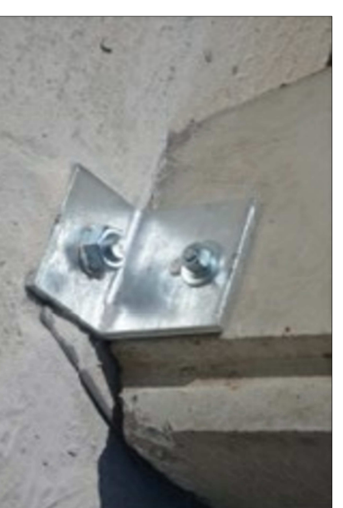
PARTICOLARI FISSAGGIO IN PIEDE E IN TESTA
