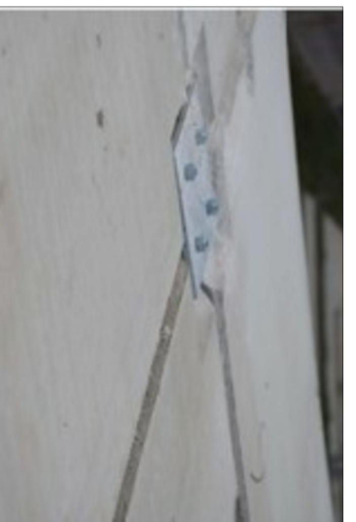
PARTICOLARI FISSAGGIO IN PIEDE E IN TESTA
